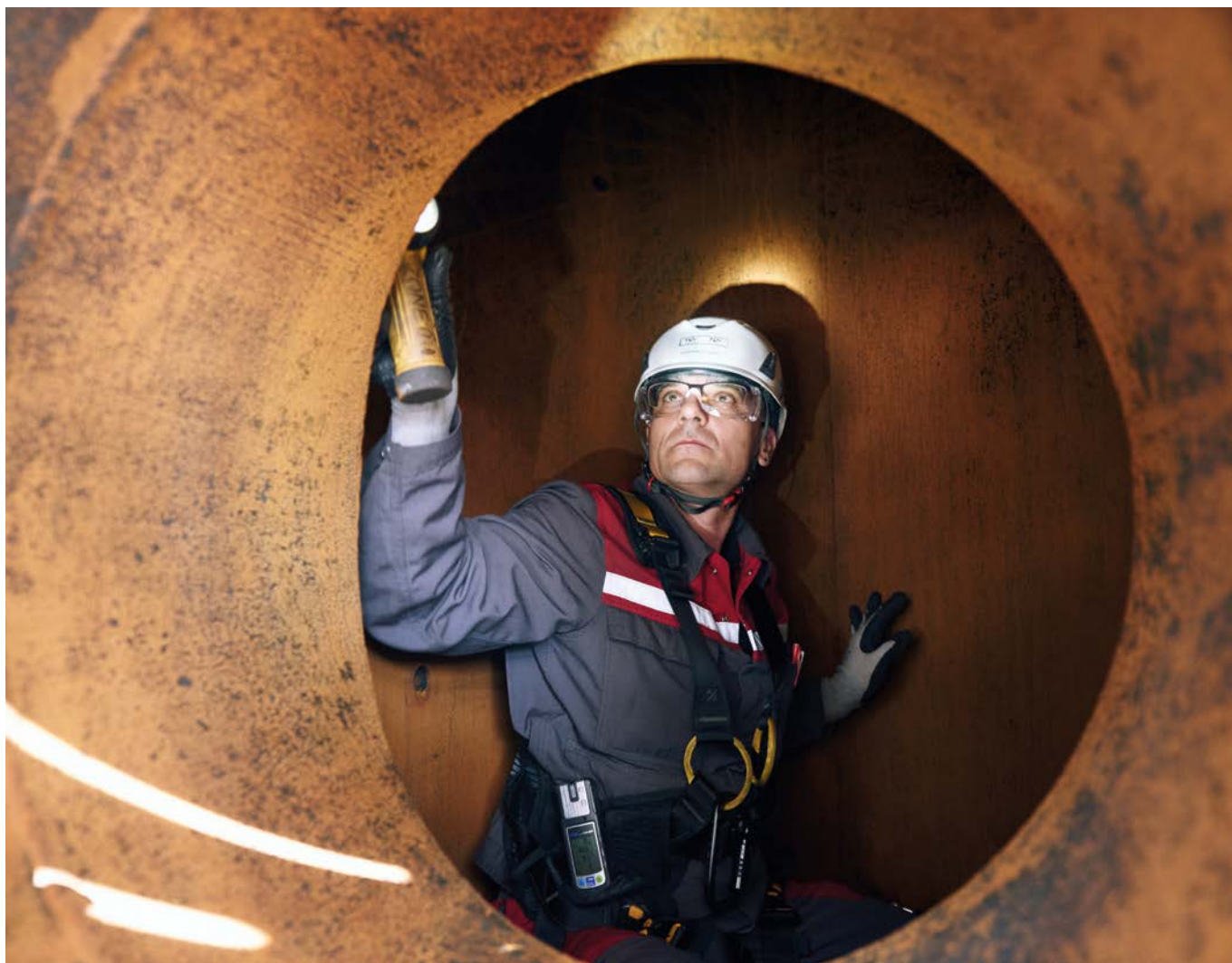
Prüfung in einem Tank. | Inspection inside a tank. Foto | Photo: OMV, Kurt Prinz
