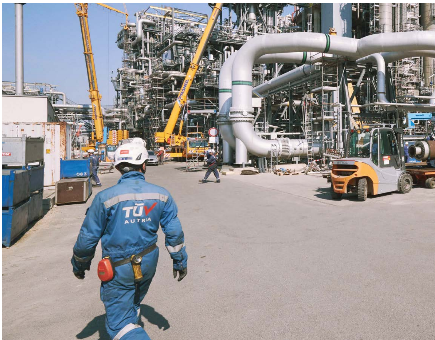
Die Petrochemie der Raffinerie Schwechat stand im Fokus der TÜV AUSTRIA-Inspektoren. | The TÜV AUSTRIA inspectors' focus was on the Schwechat refinery petrochemical facility Foto | Photo: OMV
